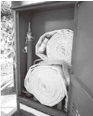
盗難防止が施された消火用筒先
