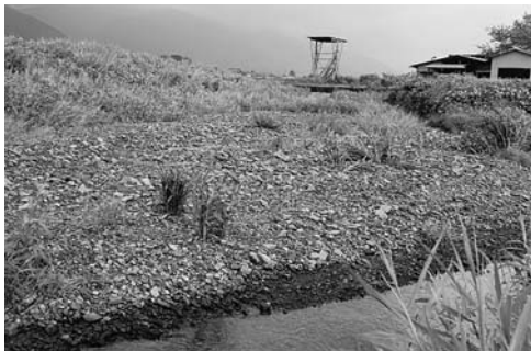
土砂で埋まった杭瀬川と大津谷合流点
