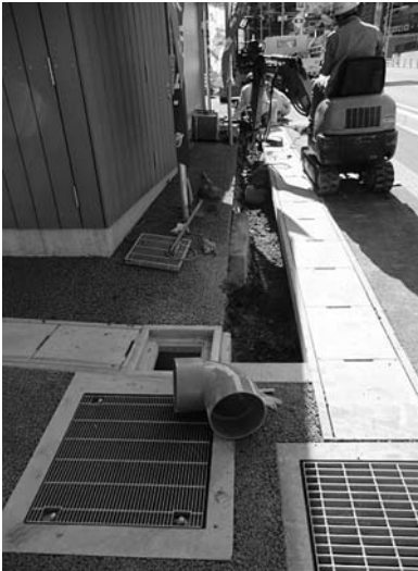
排水路の改修工事 (道の駅 9月28日)
