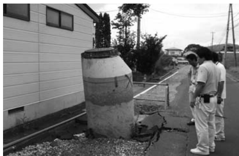
液状化により浮上したマンホール。震度6強の国見町ではほとんどのマンホールが浮上している。
