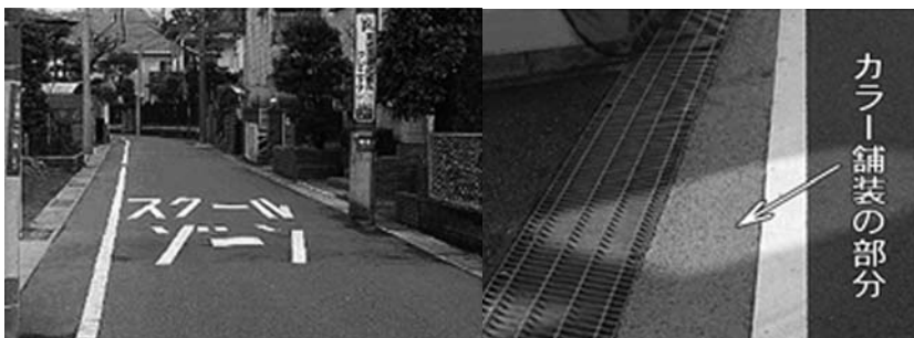
路面表示とカラー舗装の例
