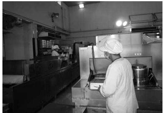
老朽化した食器食缶洗浄機（学校給食センター）
