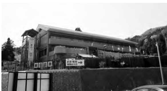
リニューアル改修工事ににかかる池田温泉
