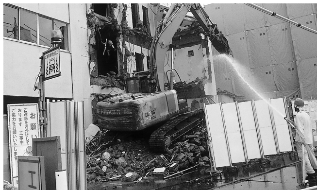
ほこりと騒音に配慮して解体工事始まる
