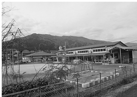
老朽化が目だつ片山保育園・園舎
