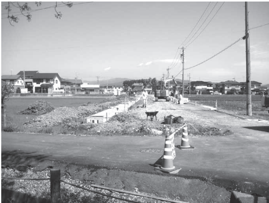
池野駅北の道路改良工事・用水路工事
