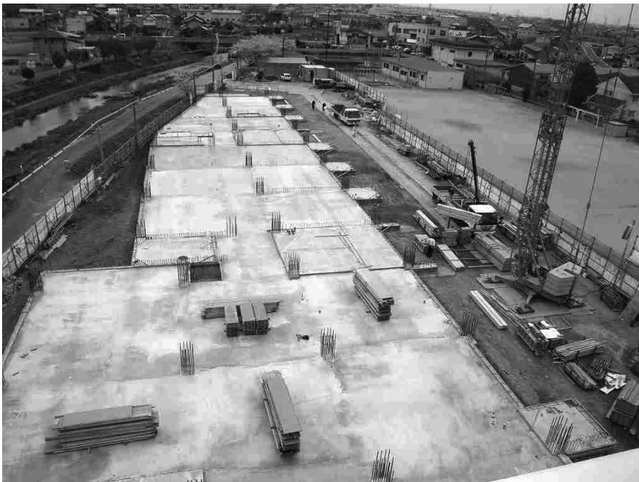
土間コンクリートができ、仮枠の建込みが始まった八幡小学校改築工事
