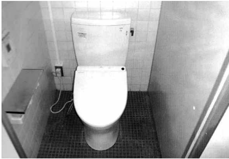
耐震化に合わせて他の箇所も洋風便器設置を！
