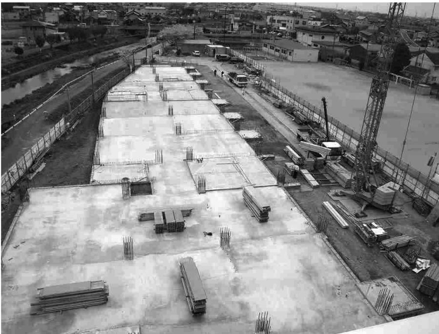
土間コンクリートができ、仮枠の建込みが始まった八幡小学校改築工事
