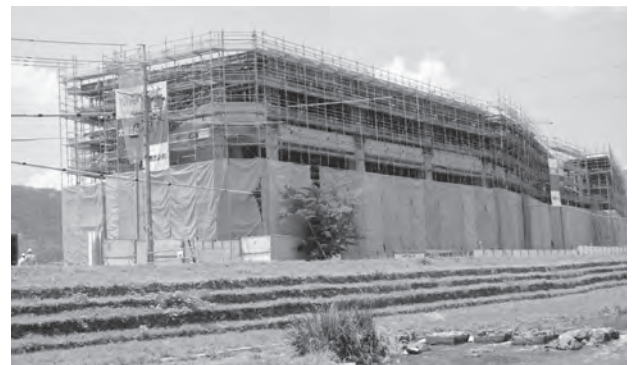
八幡小学校校舎改築工事
