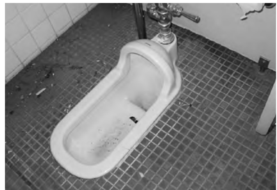
和式トイレを洋式化へ（池田小学校）
