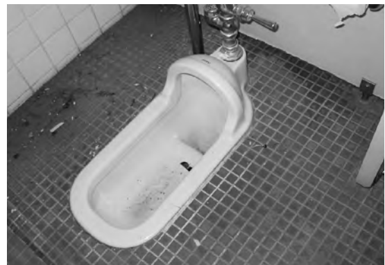
和式トイレを洋式化へ（池田小学校）
