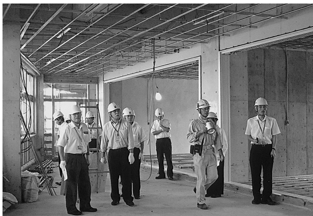
内装工事が順調に進んでいる。
