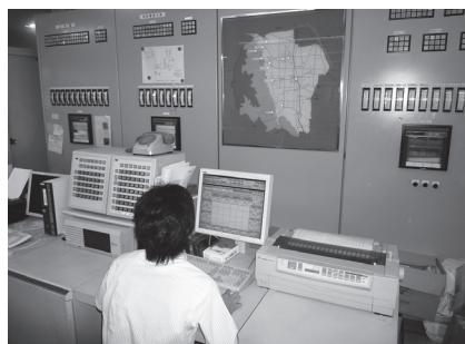
流量を中央監視盤で確認（水道課）
