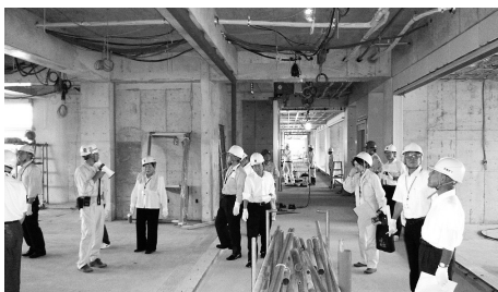
本年12月完成予定の八幡小学校校舎改築工事（空調用ダクト）
