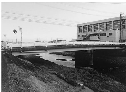
橋の老朽化対策が急務（八幡地内）
