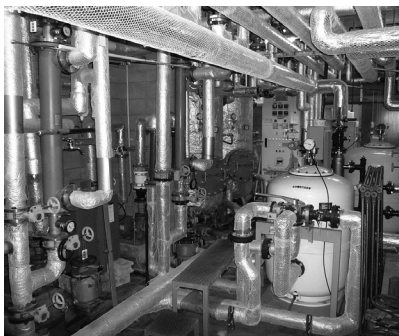
池田温泉本館機械室内部の状況
