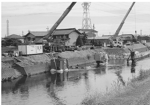
杭瀬川改修始まる（赤坂地内）
