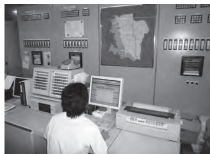
流量を中央監視盤で確認（水道課）
