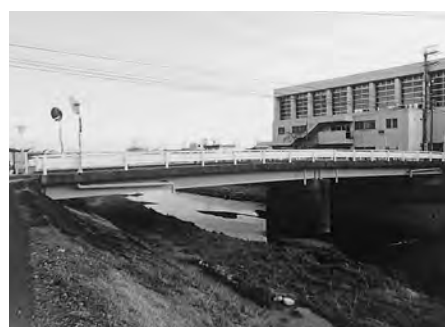
橋の老朽化対策が急務（八幡地内）
