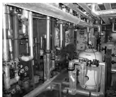
池田温泉本館機械室内部の状況
