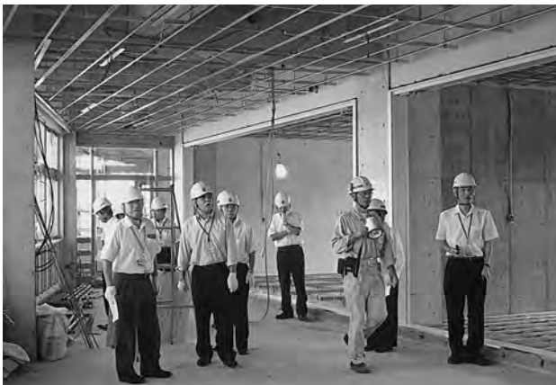
内装工事が順調に進んでいる。
