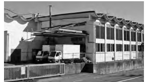
築後35年経過した学校給食センター(草深地内)
