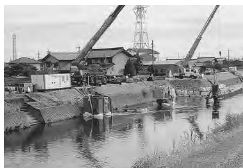
杭瀬川改修始まる（赤坂地内）
