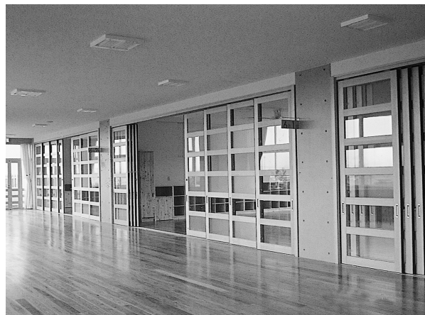
多目的ホールと教室との間仕切
