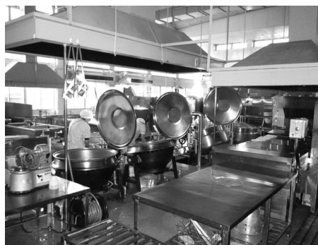
◀建物も機械設備も老朽化（学校給食センター）
