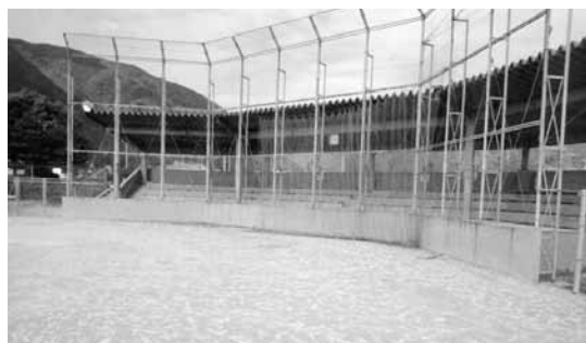
バックネットのコンクリート部分を修繕 (池田公園野球場)
