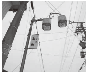
▲街路灯や防犯灯の統一した維持管理が望まれる（上町地内）
