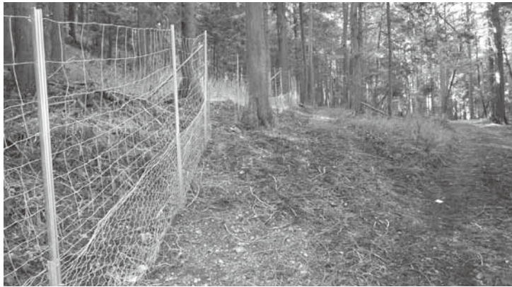
鳥獣被害防止柵を山麓一帯に設置（願成寺地内）
