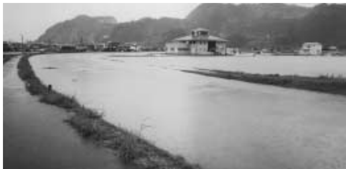
平成14年7月 台風6号により一面海のような。建物は、公共下水処理場
