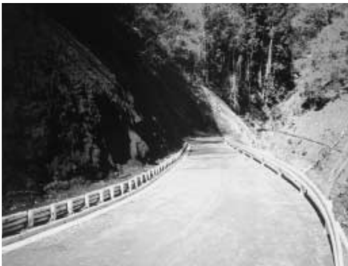
整備された池田山平成林道
