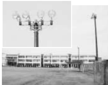
完成した池田中運動場の夜間照明
