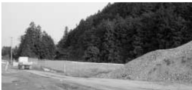
右側がトンネルの土砂、左側の奥が問題の土地
