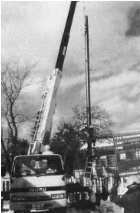
防災無線工事(継柱)地上高14m90cm
