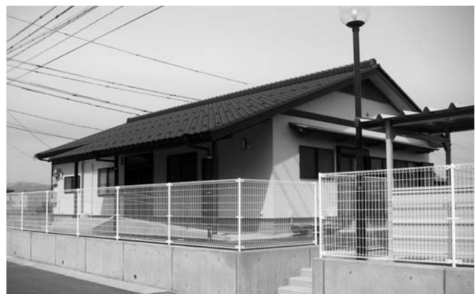
町の防災コミュニティセンター（市橋）
