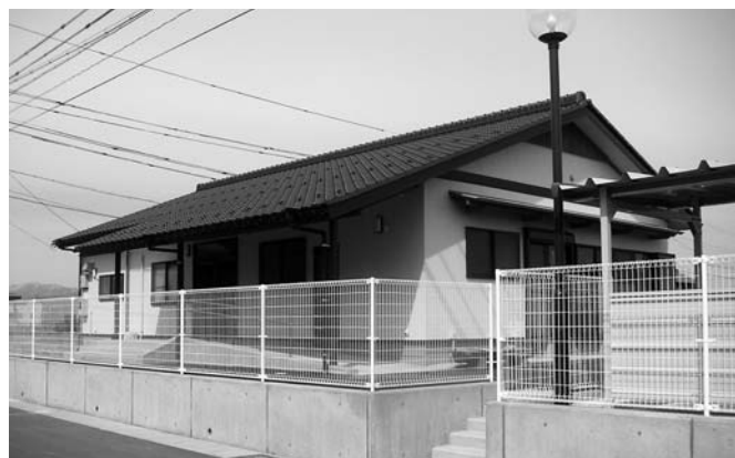
町の防災コミュニティセンター（市橋）
