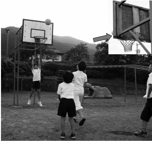
ボードが腐ってこわれそう。早く直して（藤代）
