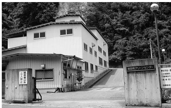
池田町クリーンセンター
