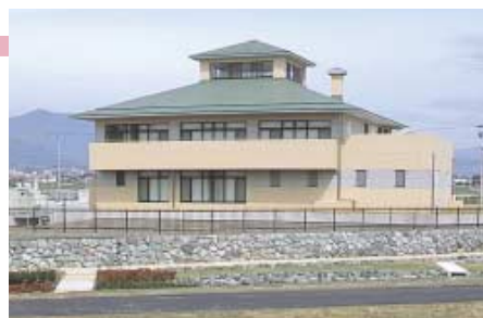
池田浄化センター
