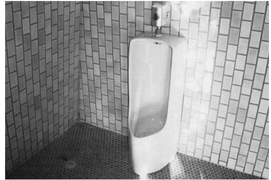
設置された小便器
