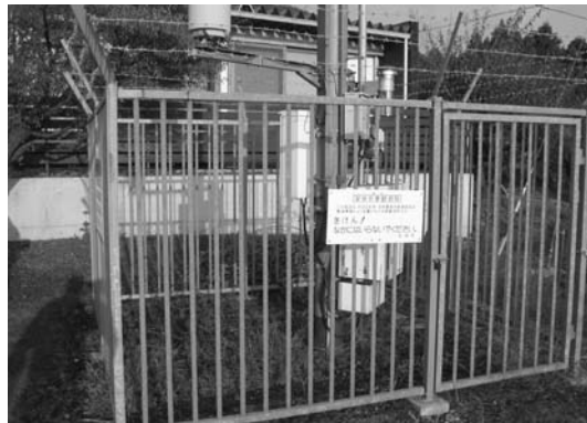
ずっと故障中の大津谷気象観測装置
