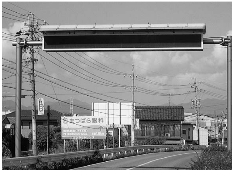
故障中の国道417号線電光掲示板
