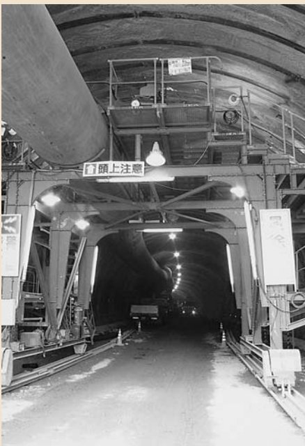
現在200m堀削 残り300m余りで接続
