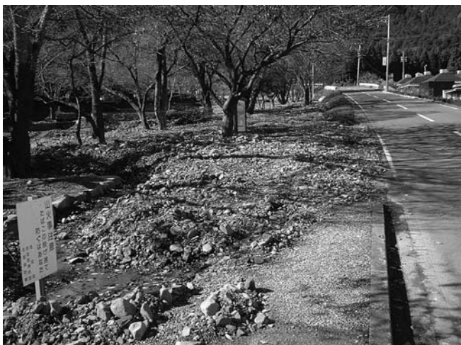
大津谷公園の土砂流出現場
