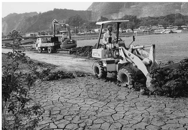
南部公園グランド流入土の撤去
