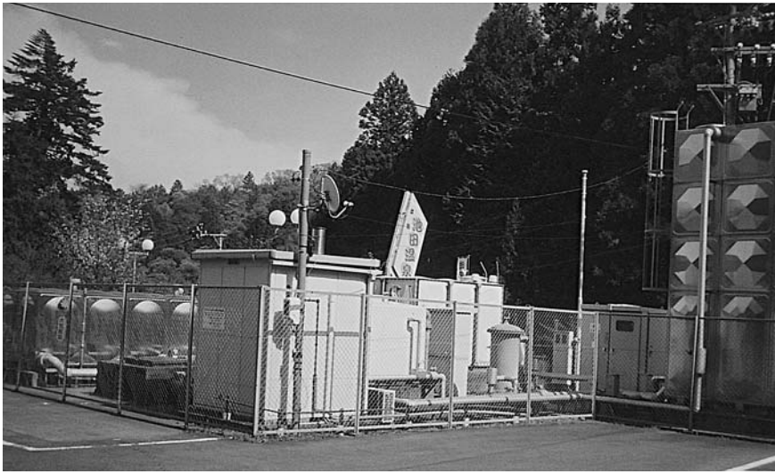
池田温泉源泉ガスセパレータ工事箇所
