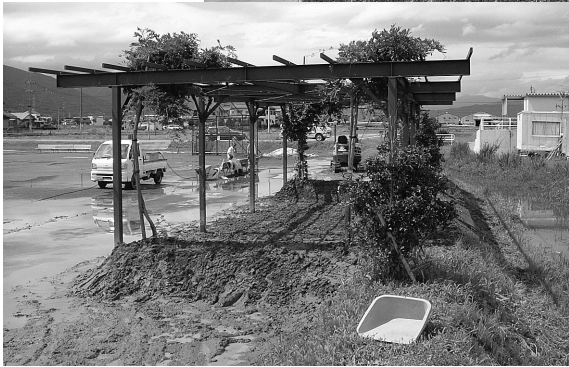
藤棚が設置される南部公園（上：工事前、下：工事中）
