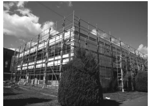
中学校北舎塗装工事
