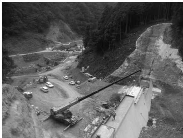
災害復旧工事中のコウトケ谷～大津谷
