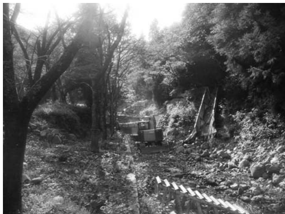
災害復旧工事中の鎌ヶ谷（霞間ヶ溪）
