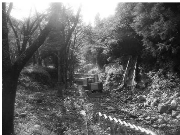
災害復旧工事中の鎌ヶ谷（霞間ヶ溪）
