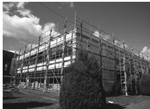
中学校北舎塗装工事
