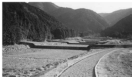
海津市南濃の羽根谷だんだん公園 砂防のモデルとも言われる。広い河道と、いくつもの堰堤があばれ谷の流れを安定化した。
