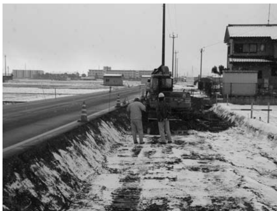
東幹線の拡幅工事（ガソリンスタンド～池田高校）
