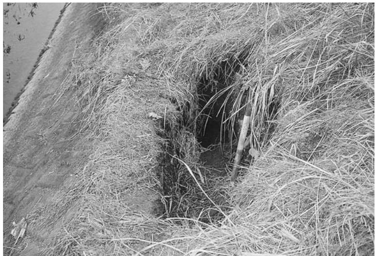
ヌートリアによる河川堤防の穴
