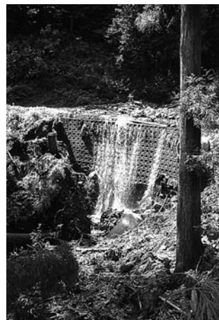
天神山林道の被災状況
