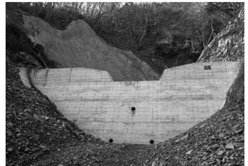
萩ヶ谷での治山谷止工
