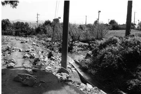
ゲリラ雨による山麓地帯での土砂流出
