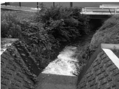
改修が望まれる堤防 (左側の草の部分) 井振谷
