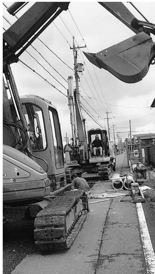
下水道管の設置風景
