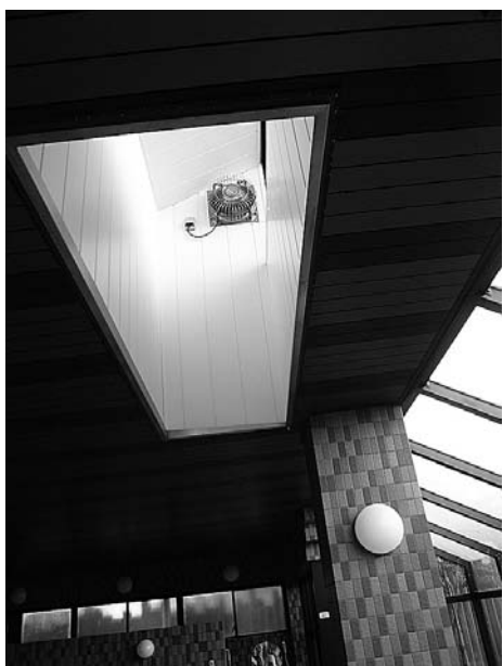
池田温泉新館の大浴場の天井板。落下部分はすぐ補修された。
