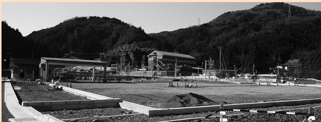
工事現場全景（1月11日現在）
